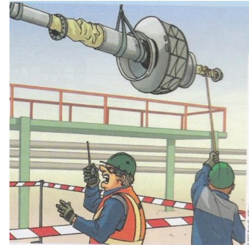
*Dependendo do tipo de levantamento, a elaboração de um protocolo ou uma autorização de elevação é obrigatório. É elaborado com a Vigier Ciment, empresa externa e levantador antes do início das manobras.*
